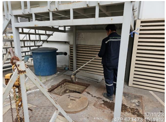
จุดระบายน้ำเสียจากระบบบำบัดทิ้งที่ออกจาก ส่วนตกตะกอน ชุดที่ 3
